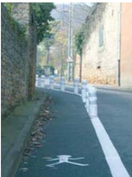
Sécurisation de la rue Rochon
