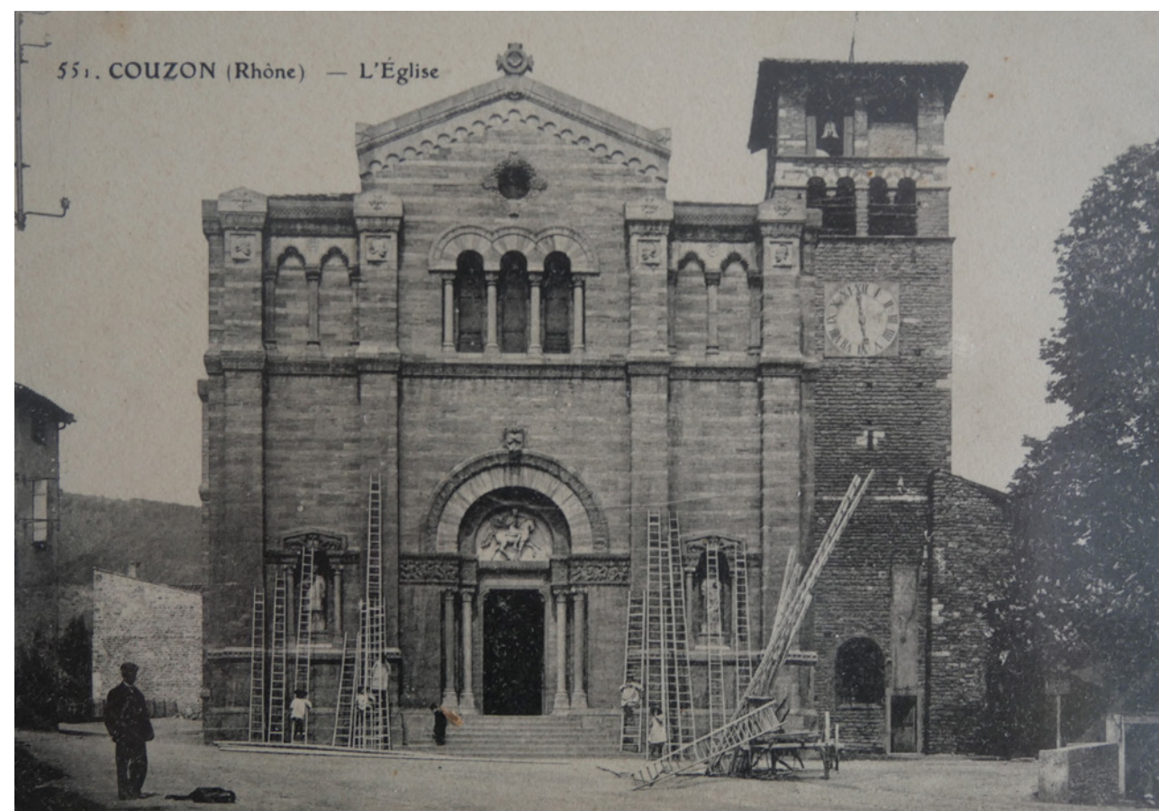
Carte postale ancienne, travaux à l'échelle [Collection particulière - tous droits réservés]
