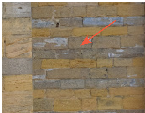
Pose de pierre de Ciret dans des rangs de pierre de Couzon
