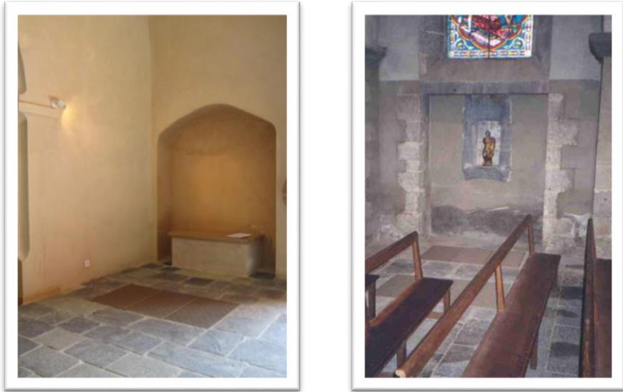
exemple de bouches de sol
