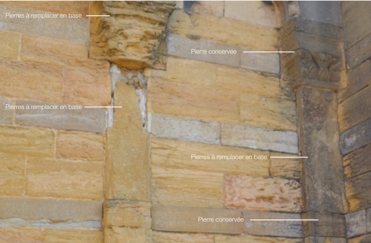
Pierres à traiter au mortier de ragréage en base et/ou à remplacer en option
