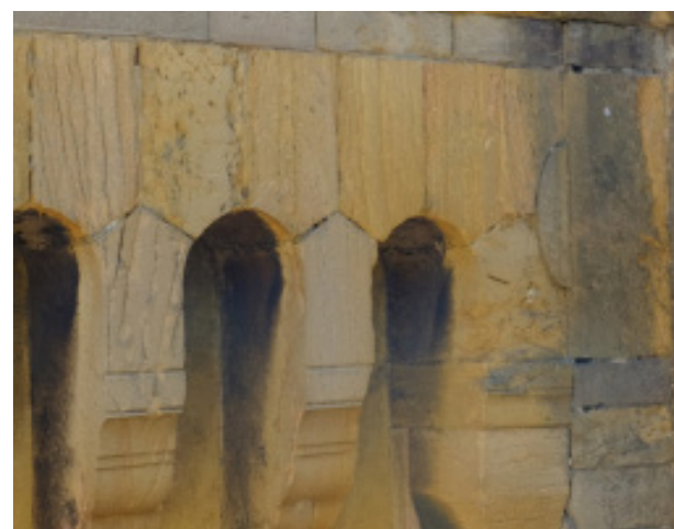
Aracs supportant la corniche de l'abside posés en délit
